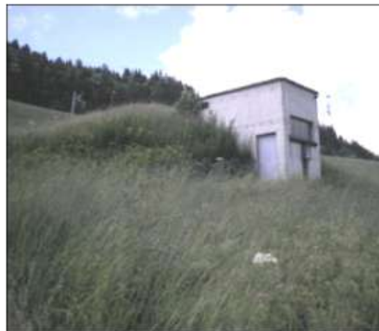
Figure 3 : Le réservoir des Varins, 500 m 3
