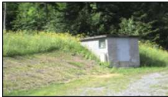
Figure 2 : Le réservoir des Grabilles, 200 m 3
