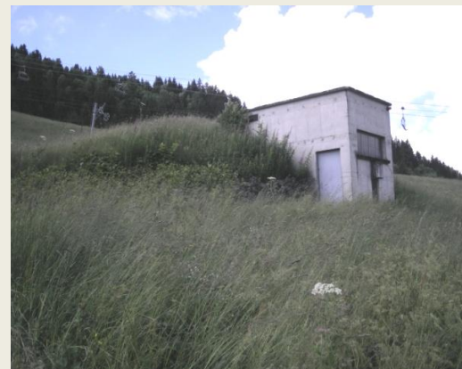
Le réservoir des Varins
