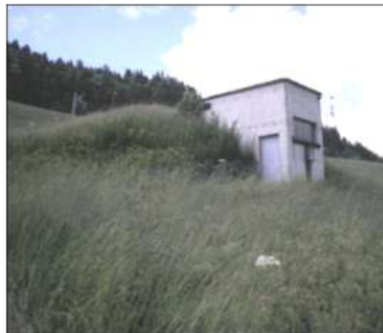
Figure 3 : Le réservoir des Varins, 500 m 3
