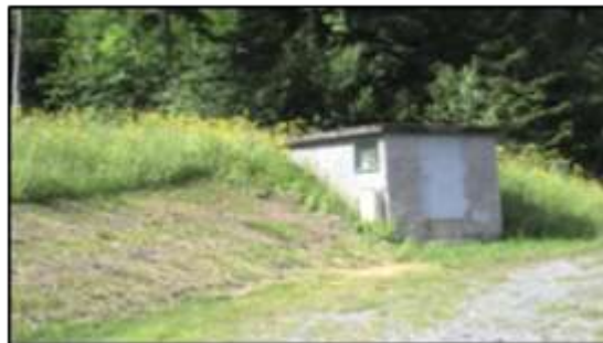
Figure 2 : Le réservoir des Grabilles, 200 m 3
