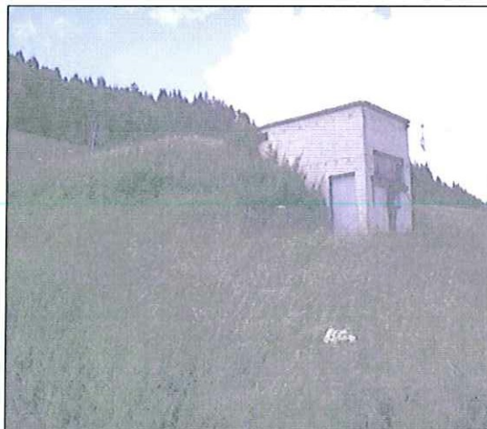
Figure 6 : Le réservoir des Varins, 500 m 3
