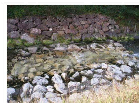
PRA-07 : Seuil dans le lit de l'Arly au niveau de la station d'épuration
